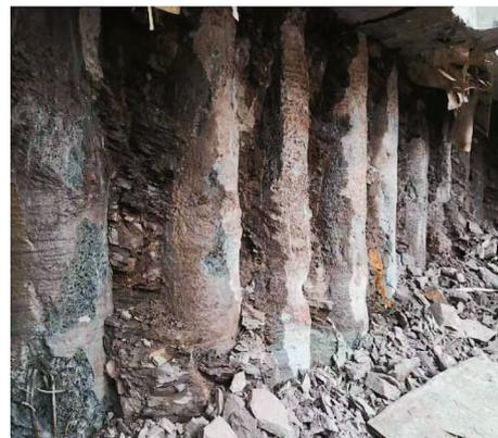
图 6 钻孔灌注桩现场施工效果
